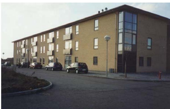
Facade mod parkeringsarealer.
