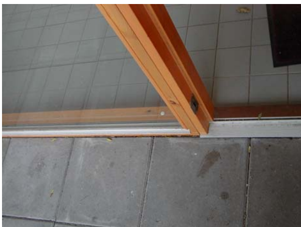
Vindue og dør til trapperum
