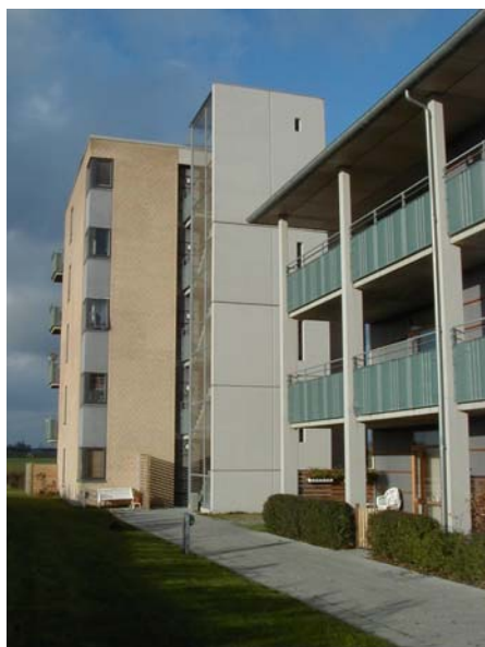
Punkthusets trappe- og elevatortårn.
