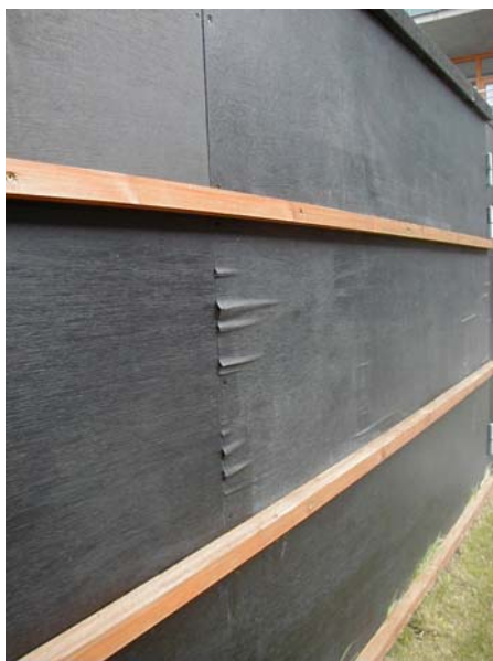
Delamineret krydsfiner på skure
